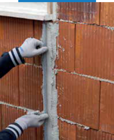
Установка вертикальных направляющих маяков
