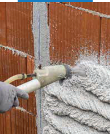
Нанесение Intomar 535 (Интомап 535) с помощью штукатурной станции
